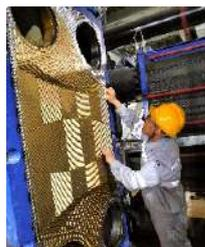
近日，#1机闭式水温度持续升高，检修维护部汽机检修针对系统进行全面排查，在排查中发现#1机B闭式水换热器存在堵塞风险，遂对换热器进行了解体清理。解体检修后，1B闭式水换热器换
